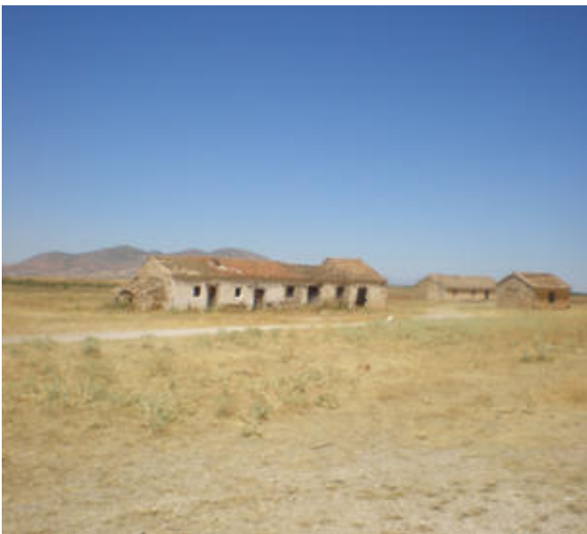
Entorno Estación de Tren (Huélago)
