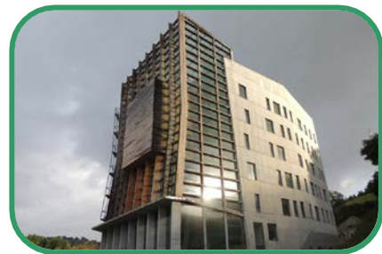
Edificio EnerTIC San Sebastián. Fuente: www.construible.es
